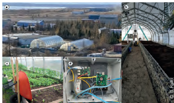
Serres de Kuujuaq (a), pour lesquelles un système de stockage innovant a été mis en place (b) afin d'allonger la saison de culture (c). Un suivi des performances du système est permis grâce à une instrumentation spécifique développée dans le cadre du projet (d)
